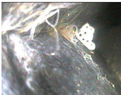
Coibentazione interna con rilievo di un alveare
